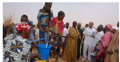
Sur le site d'une adduction d'eau potable au village de Djagourou
