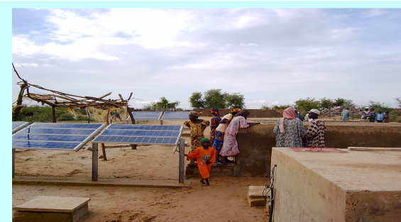
Installation d'équipements de la Mini AEP dans le village d'Abuja.
